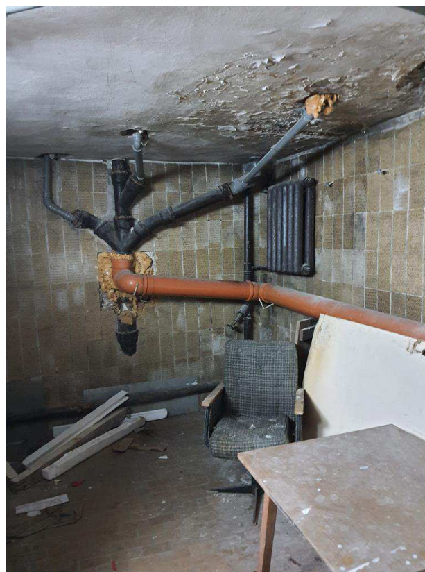
Fot. 13, 14. Korytarz w piwnicy, jeden z rozdziałów dolnych kanalizacji.
